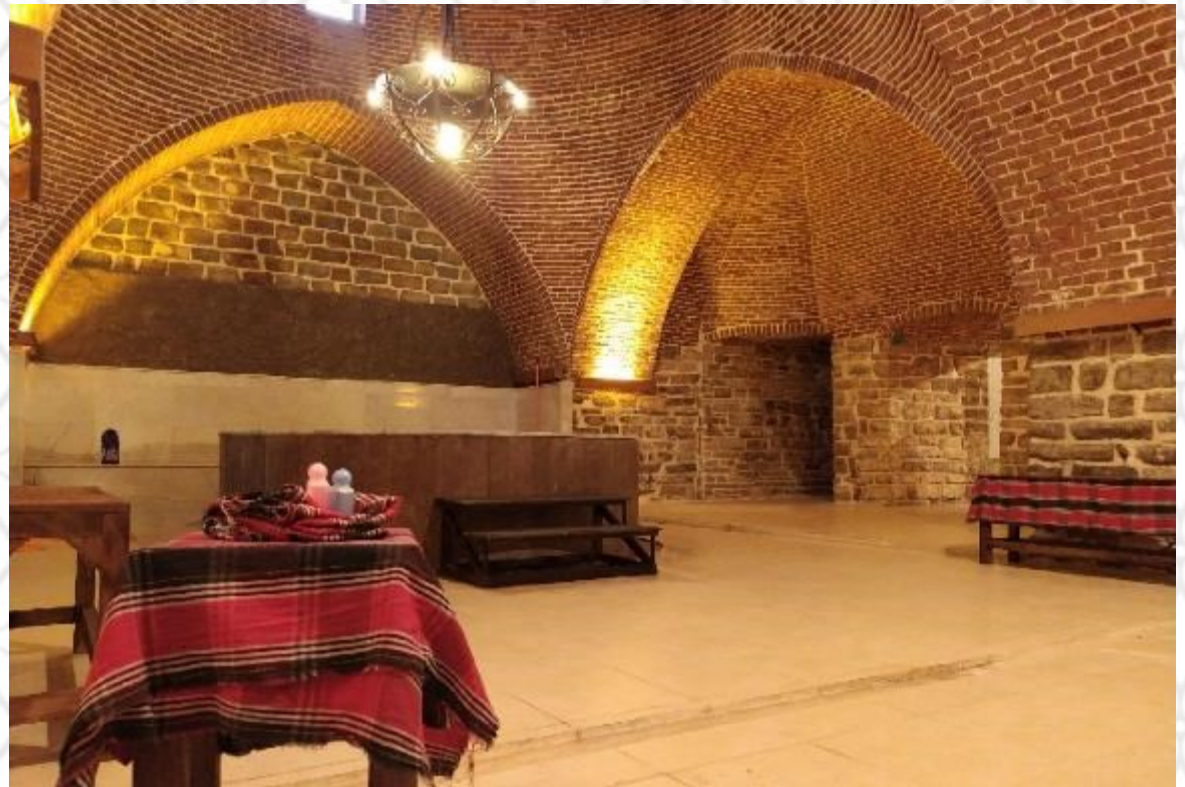
مجموعه تاریخی: حمام اتحادیه استان: آذربایجان غربی
