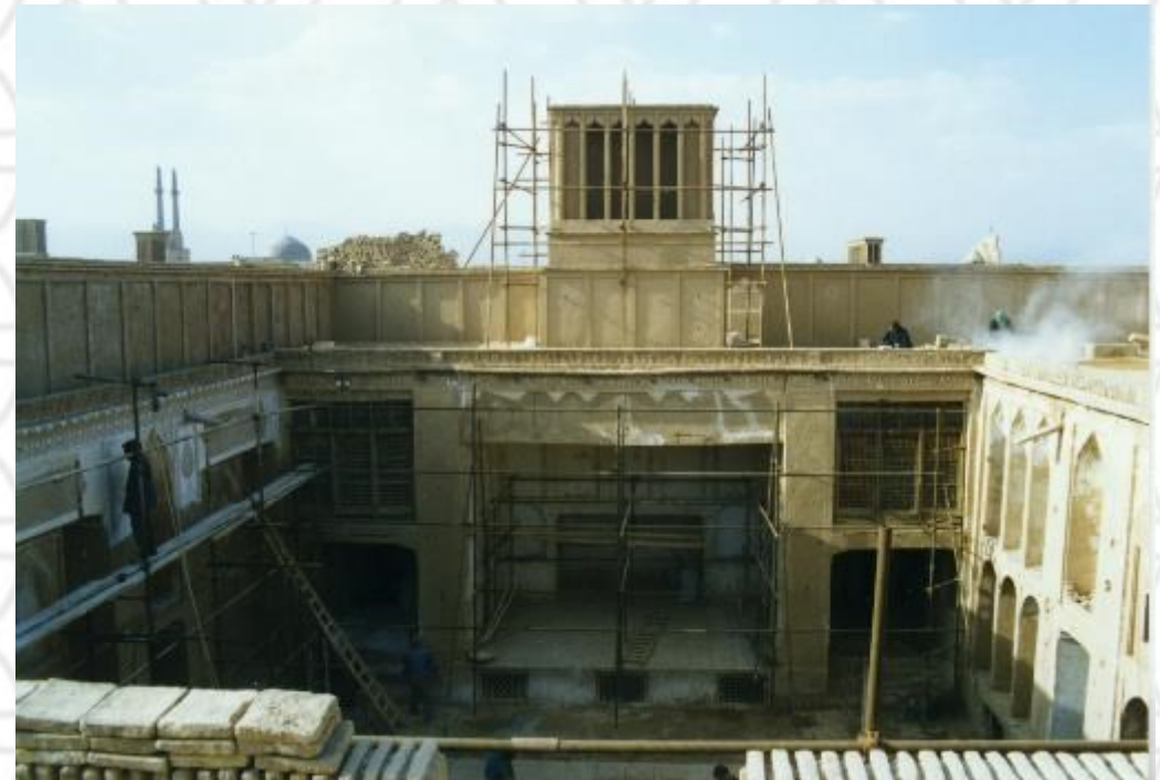
مجموعه تاریخی: مجموعه خانه های فهادان استان: یزد
