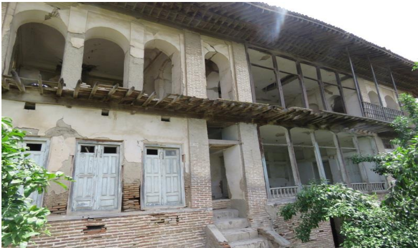
تصویر شماره ۹- نمای خارجی ساختمان غربی
