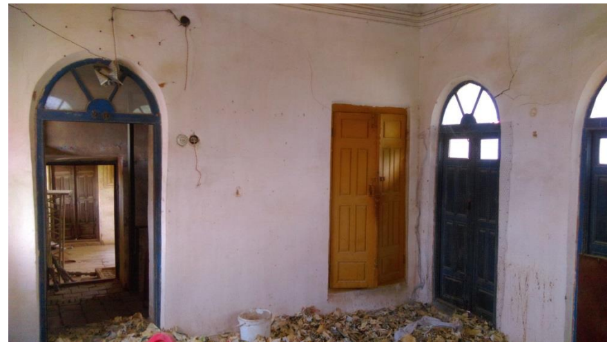
تصویر شماره ۸ فضای داخلی ساختمان شرقی
