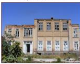
خانه خادم باشی قدمت بنا قاجاریه مساحت عرصه ۱۹۹۲,۹۵ مساحت اعیان ۱۱۷۲,۸
