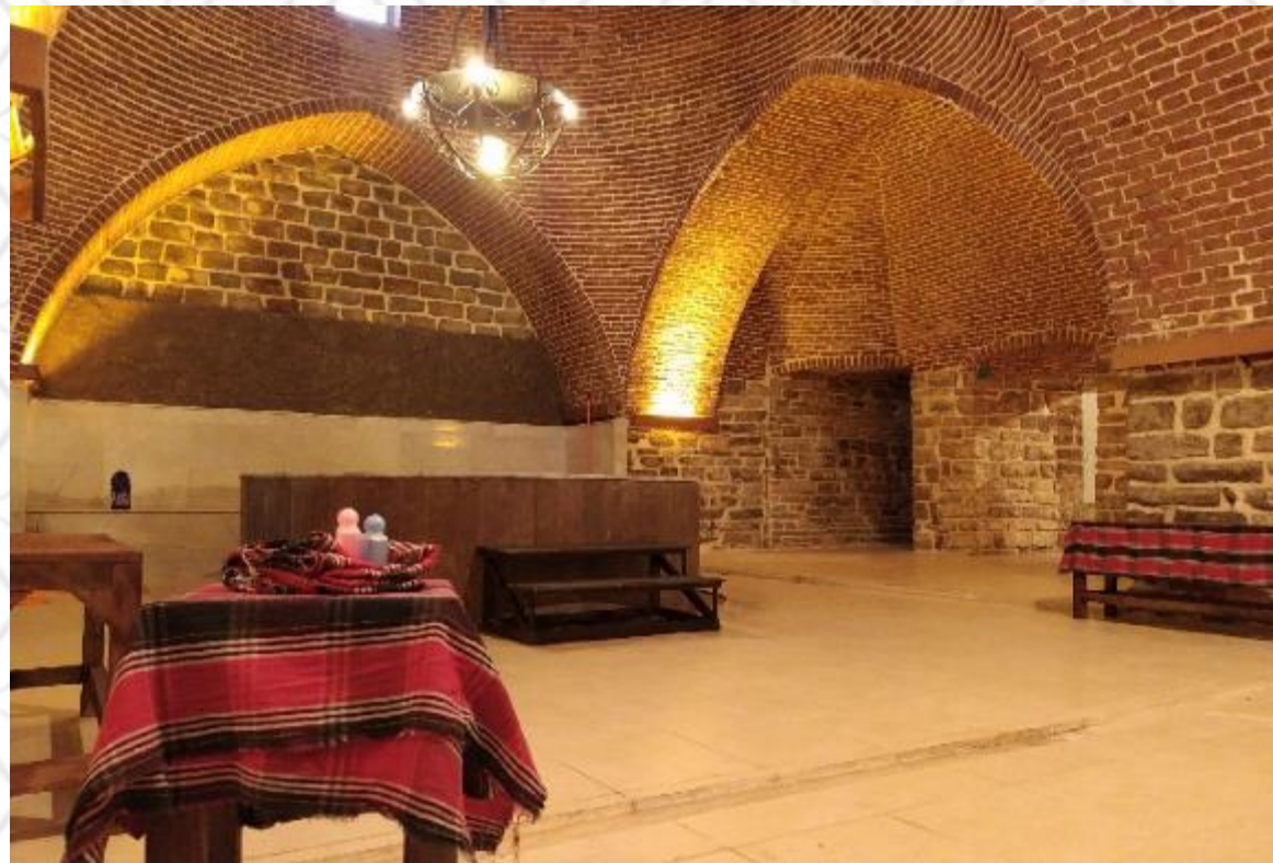
مجموعه تاریخی: حمام اتحادیه استان: آذربایجان غربی
